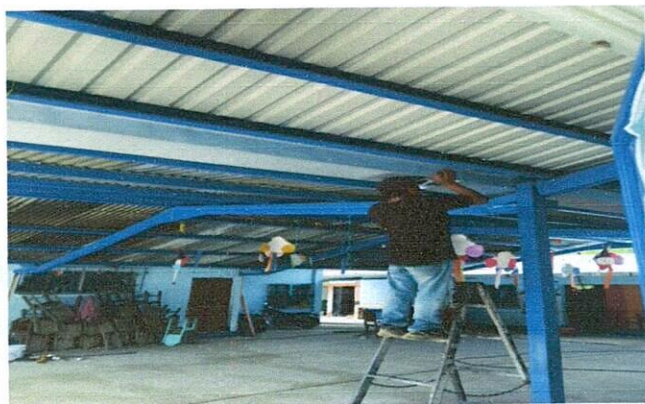
Foto 3: Instalacion de canales
