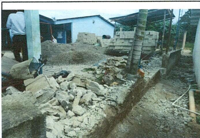
Foto 1: Mejoramiento del muro perimetral
