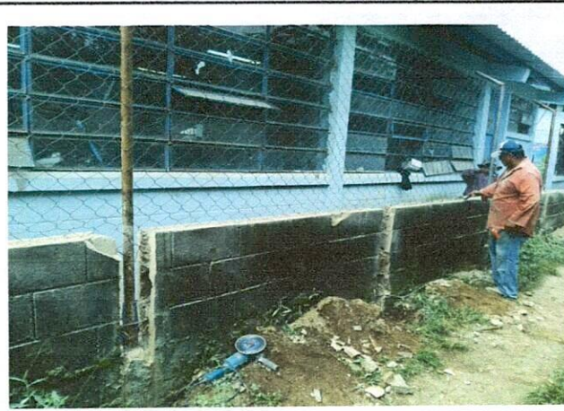
Foto 2: Mejoramiento del muro perimetral
